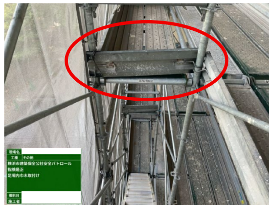
改善指示 足場内巾木設置 是正後
