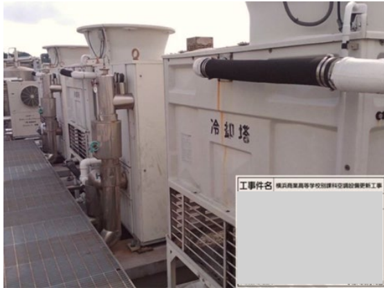
施工前（冷却塔一体型吸収冷温水機）
