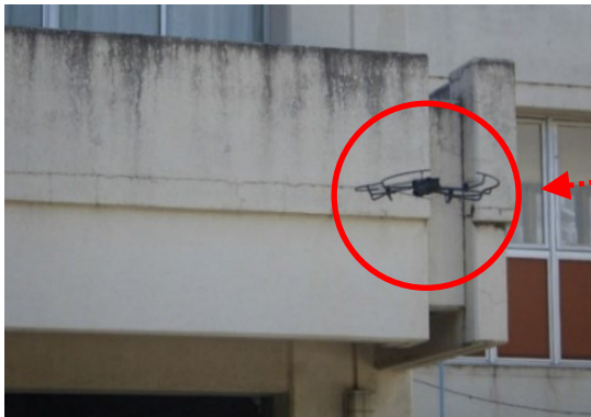
外壁調査の状況
