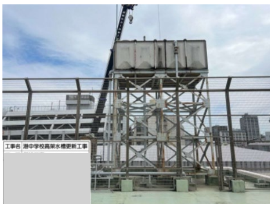
施工前（高架水槽）
