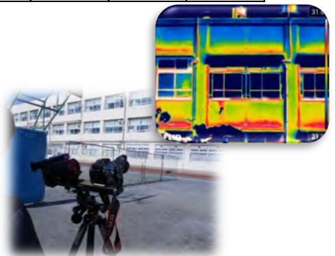
劣化調査(赤外線サーモグラフィカメラ)
