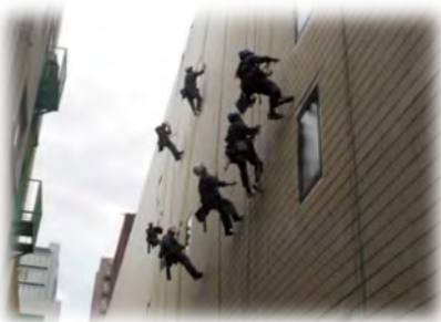
外壁点検(法定点検)
