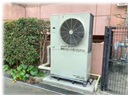
地域ケアプラザ空調機更新工事
