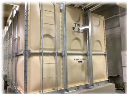
高等学校受水槽更新工事
