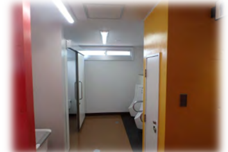
学校トイレドライ化改修工事
