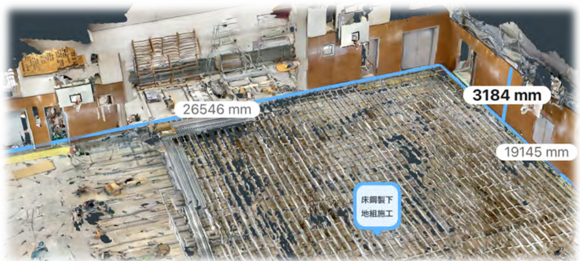
中学校体育館床改修工事 施工中
