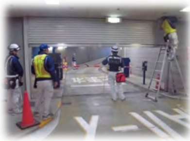
防火設備点検(法定点検)
