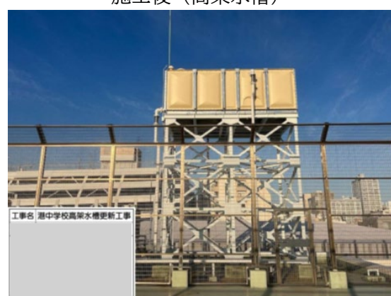
施工後（高架水槽）
