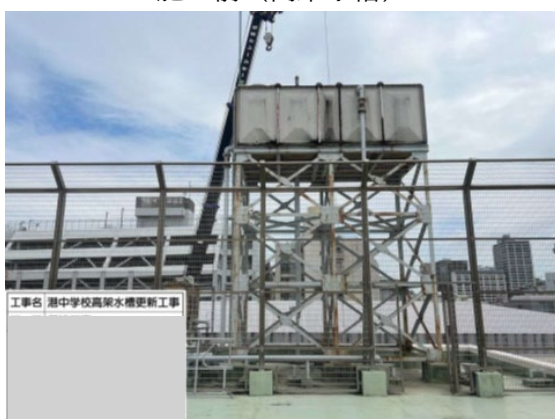
施工前（高架水槽）
