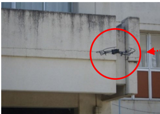
外壁調査の状況
