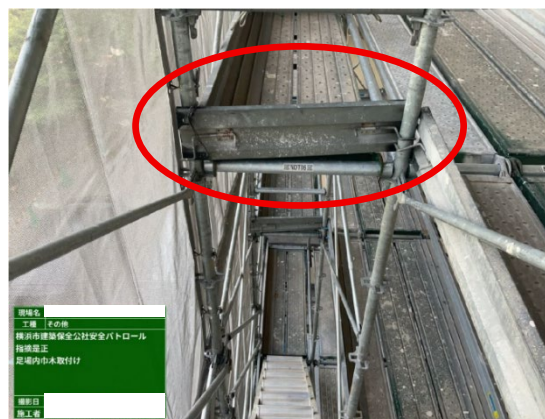
改善指示 足場内巾木設置 是正後
