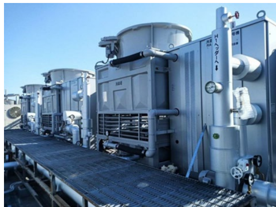
施工後（冷却塔一体型吸収冷温水機）
