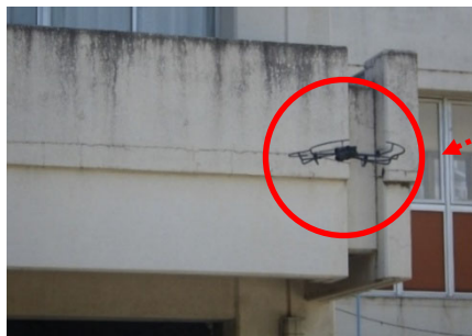
外壁調査にて職員が操縦するドローン
