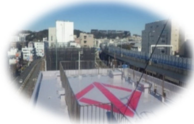
屋上防水改修
