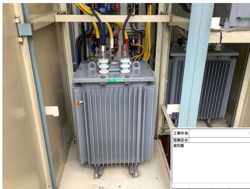
キュービクル内の変圧器、ブレーカー、高圧ケーブルなどの更新
