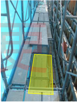
(1) 床材の損傷、取付け及び掛渡しの状態
