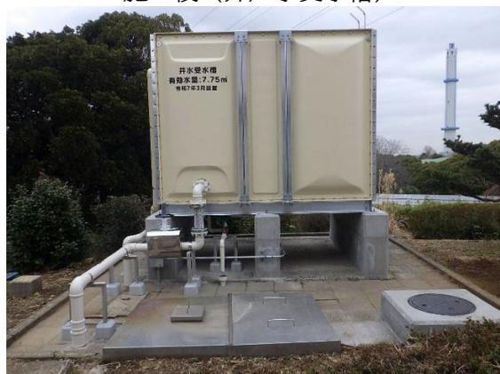
公園内の菜園に散水する井戸水を貯めておく受水槽、及び埋設されている配管（上水及び井戸水）が老朽化したため更新する工事です。
