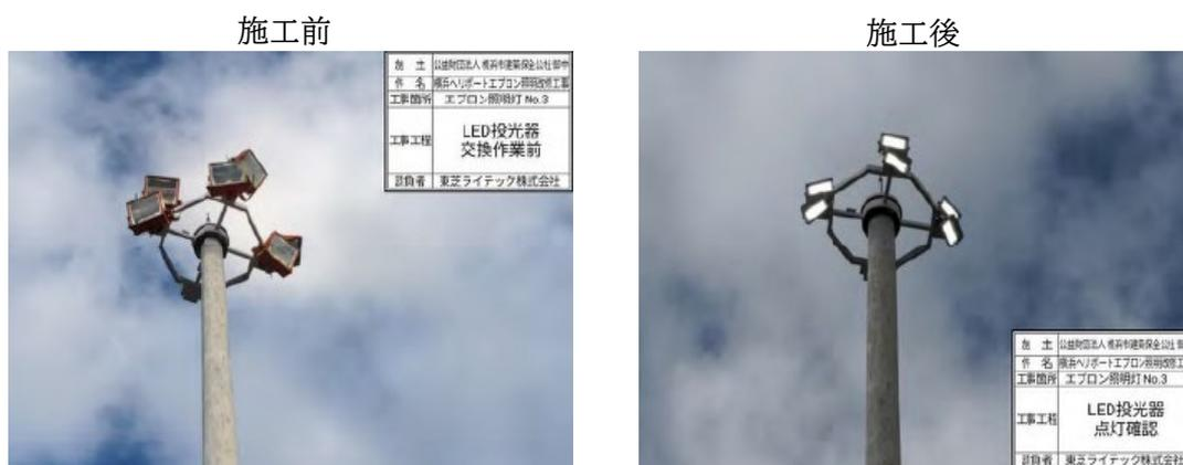
航空機駐機場（エプロン）における乗客の乗降、荷物の積み下ろし、給油、整備などの作業の安全や効率性を確保するために、エプロン照明をLED照明器具に更新しました。
