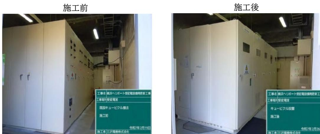
変電室に設置されている老朽化したキュービクル（閉鎖型受変電設備）を更新しました。
