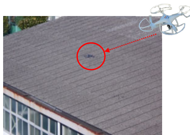
体育館屋根（写真中央にドローン）
