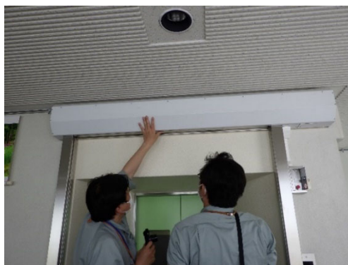
防火設備点検の様子
