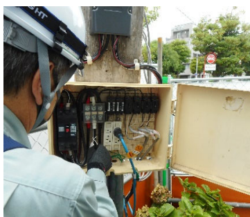
仮設電気の点検
