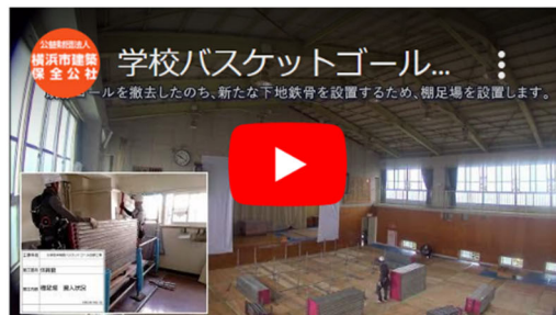
学校バスケットゴール改修工事
