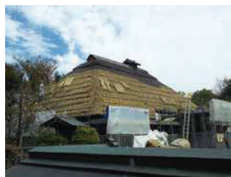
茅葺屋根 葺き替え（公園 古民家）
