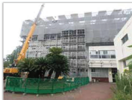
足場組立中（学校施設運営中）
