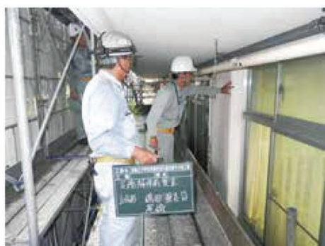
外壁改修（工事監理）
