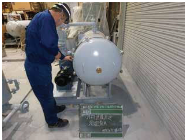
循環器設備 更新（工場検査）
