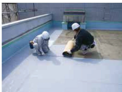
屋上防水（建物漏水対応）
