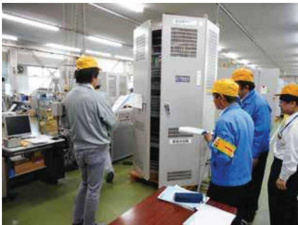
直流電源装置 更新（工場検査）
