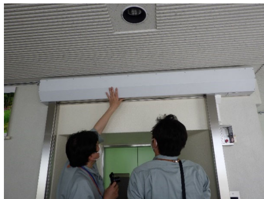
防火設備点検の様子
