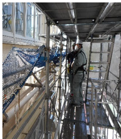
足場設置状況の安全点検
