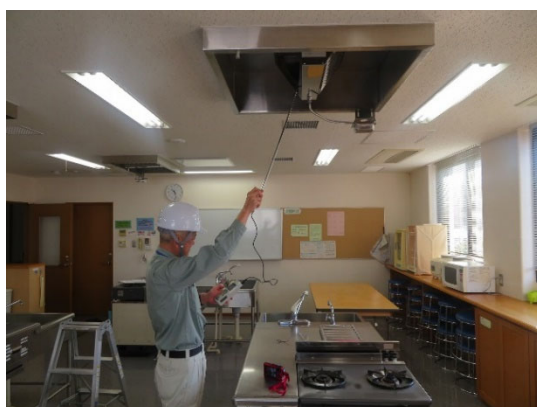
建築設備点検の様子
