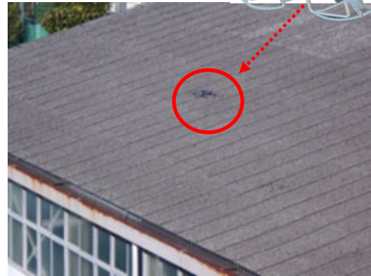
体育館屋根 (写真中央にドローン)
