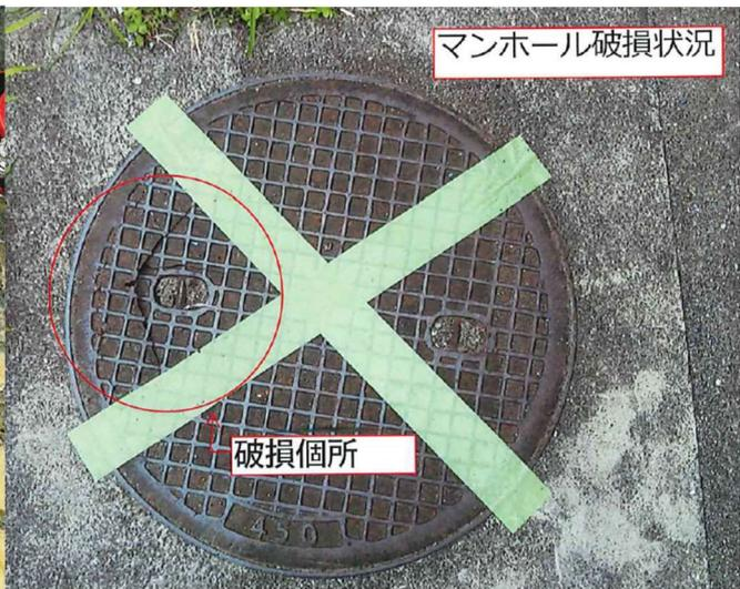
4 t トラックが載って破損したマンホール蓋
