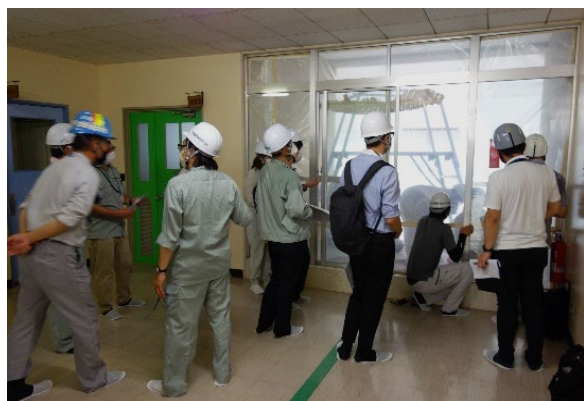
藤の木中学校：外壁改修
