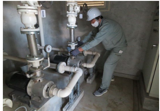
建築設備点検の様子
