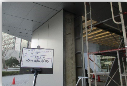
パネル撤去状況
