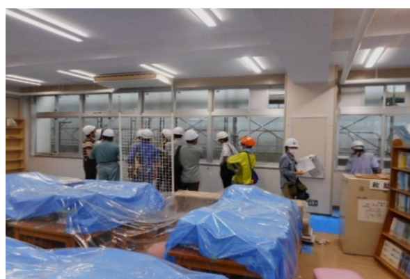
東汲沢小学校：アルミサッシ改修
