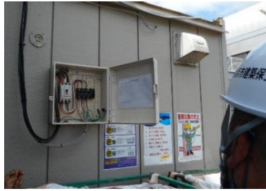
仮設電気の点検
