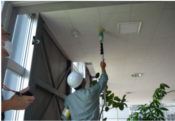
防火設備点検の様子
