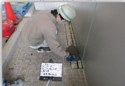
パネル撤去到に伴う床補修
