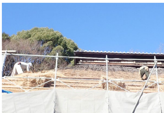
葺替工事の作業中
