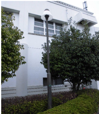
対象外灯ポール外観
