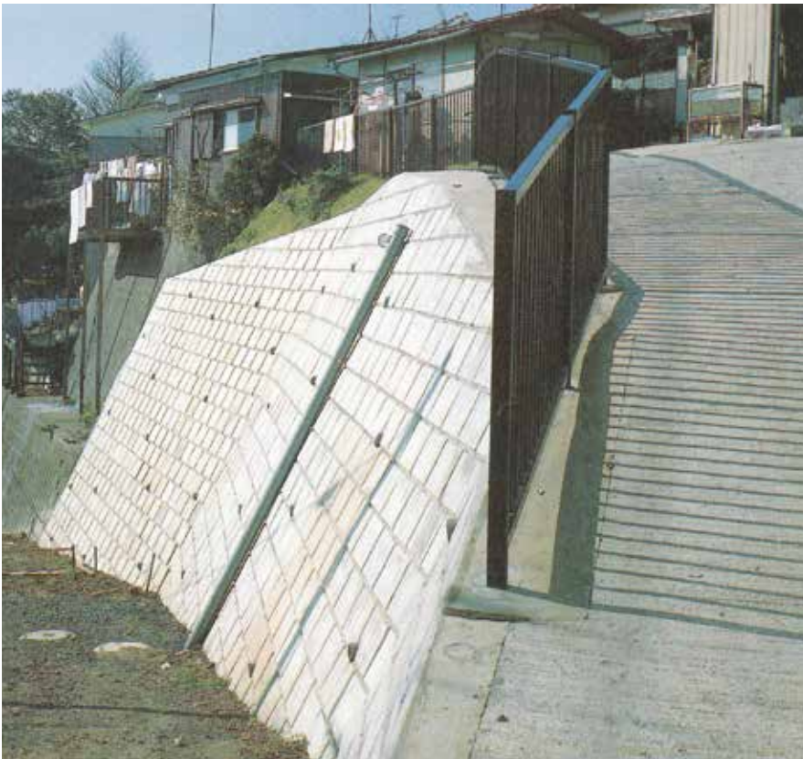
■宅地防災工事 南区清水ヶ丘
