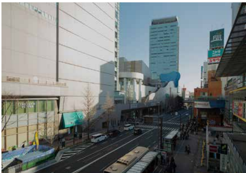
■上大岡駅西口地区市街地再開発事業（平成 9 年竣工）
