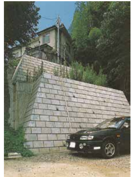
■宅地防災工事 港南区港南
