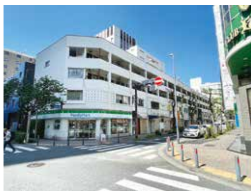
■中区弁天通 3 丁目（令和 5 年）
