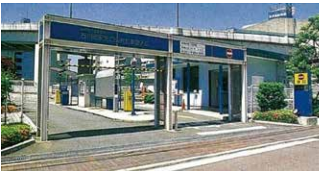
■石川町駅北口公共駐車場
