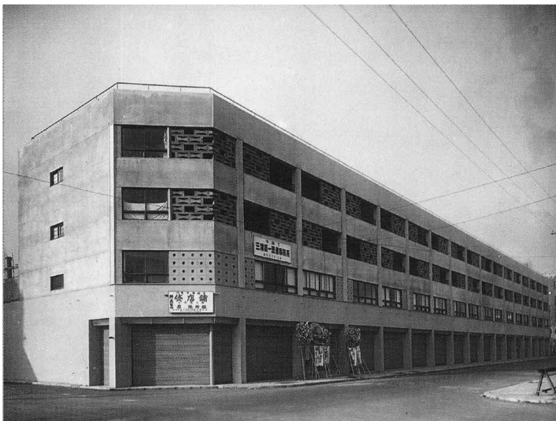
■弁天通 3 丁目共同ビル：併存住宅第 1 号
