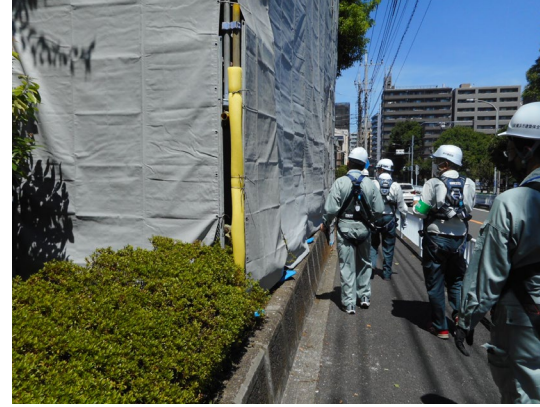
現場巡視(外周部) 2022.08.10 N小学校
