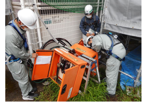
現場巡視(仮設電気) 2022.08.04 F小学校
