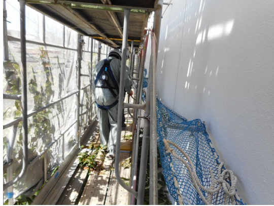
現場巡視(仮設足場内) 2022.08.10 N小学校
