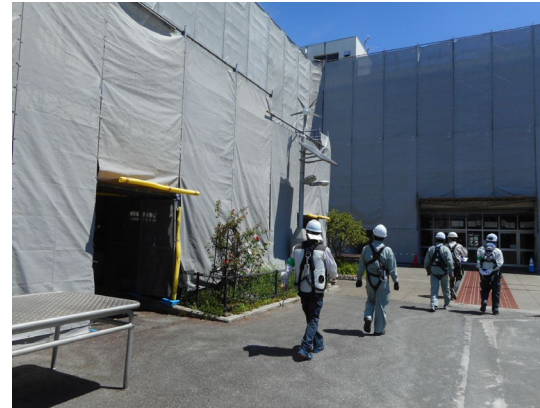
現場巡視(外周部) 2022.08.10 N小学校
