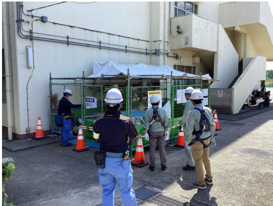
現場巡視(資材置場) 2022.09.16 F小学校
