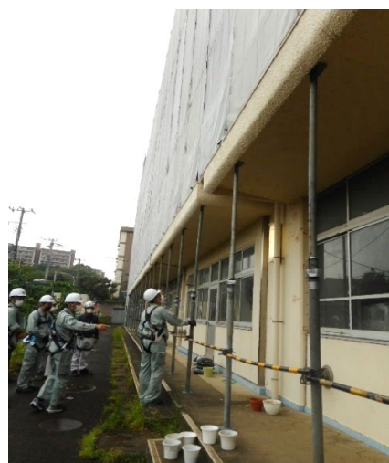
足場設置状況の安全点検
