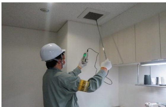
換気設備点検の様子
