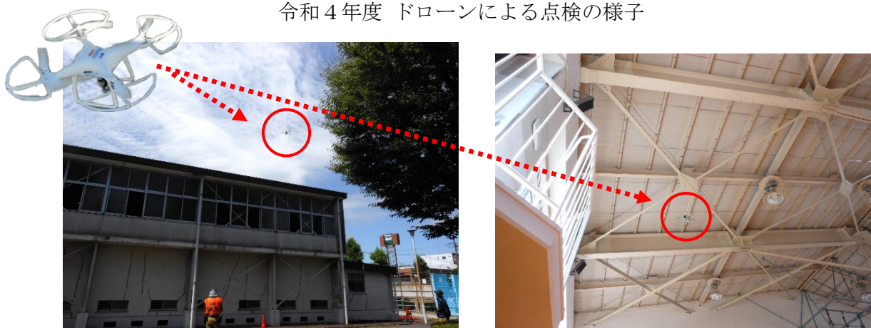
屋根 (写真中央上部にドローン)
