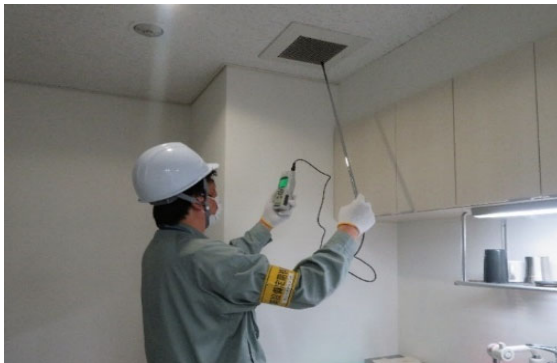
換気設備点検の様子
