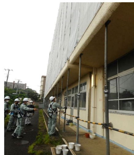
足場設置状況の安全点検
