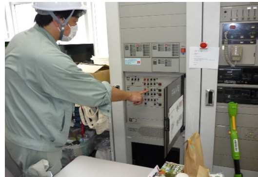
防火設備点検の様子
