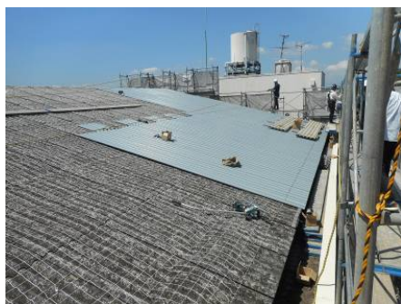
折本小学校：体育館屋根改修
