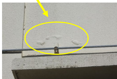
撮影写真の拡大による 塗膜膨れの状態確認
