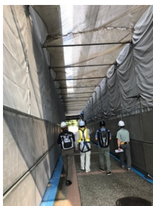
下田小学校：外壁改修
