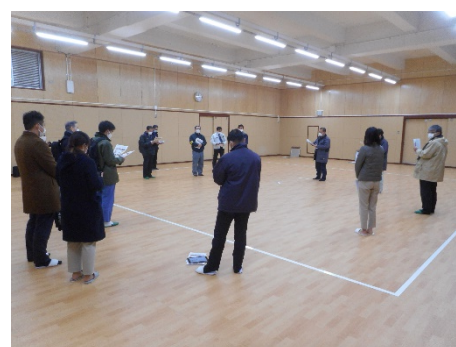
大道中学校：武道場床改修
