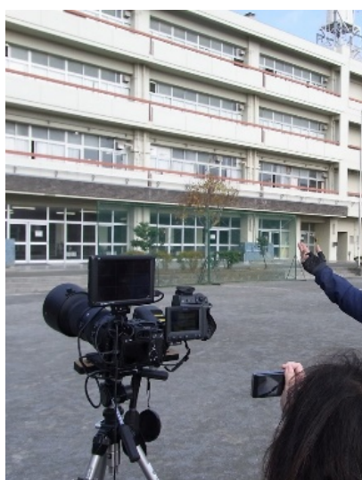
高解像度カメラによる 外壁点検の調査風景
