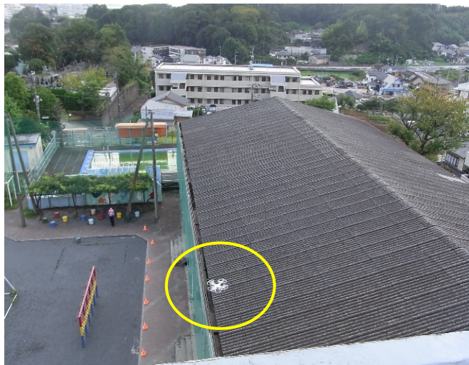
屋根（写真中央下部にドローン）
