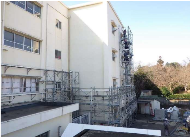
①足場組立解体作業
