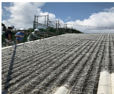
学校体育館の屋根葺き替え工事
