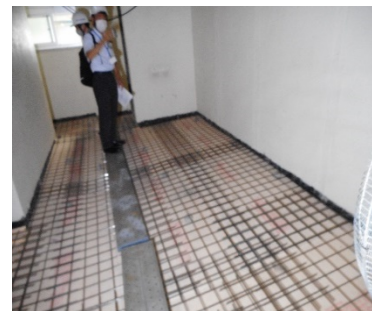
学校トイレの改修工事
