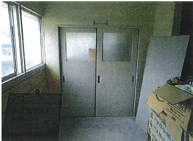
事故現場状況写真
