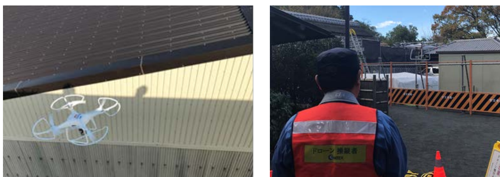
ドローンによる調査の様子
