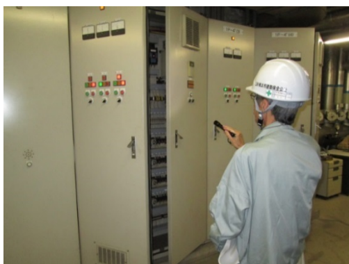
建築設備点検の様子
