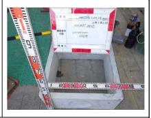
機器・配管などは、全体の写真を撮り、型番・製品名・規格などが確認できるように撮影する。
