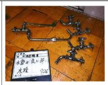
材料は床に直置きせずに、養生をした上に置く。
