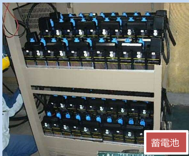
直流電源用蓄電池 改修工事
