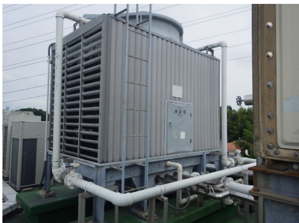
施工前（冷却塔）
