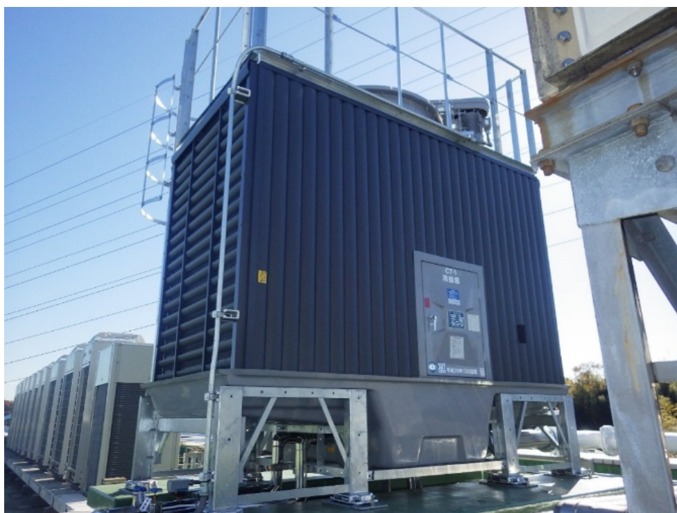
施工後（冷却塔）
