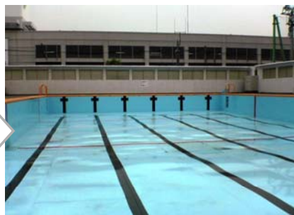
プール改修後
