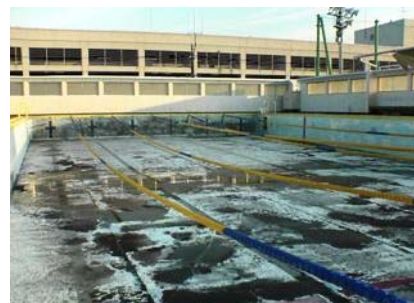
プール改修前
