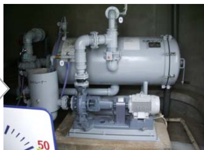
プールろ過装置改修後
