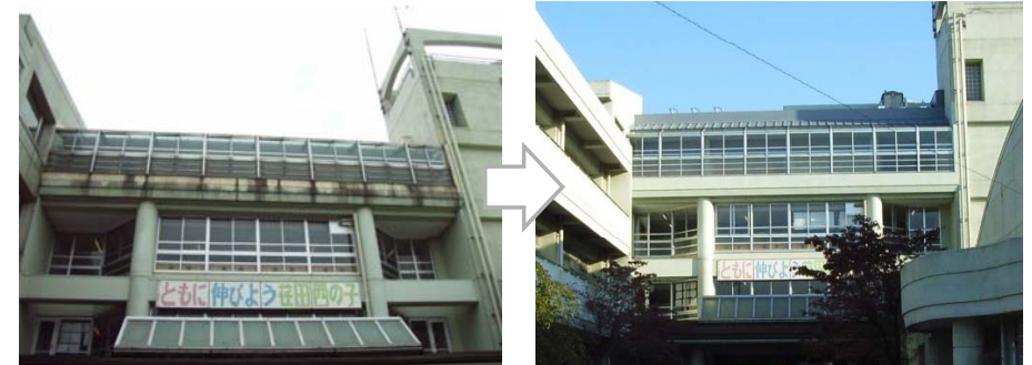
建物の外壁の改修
