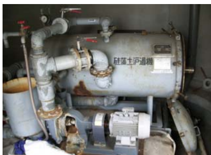
プールろ過装置改修前
