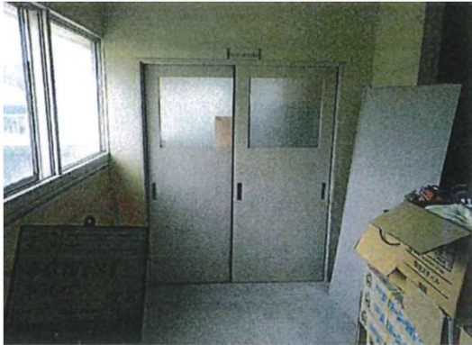
事故現場状況写真
