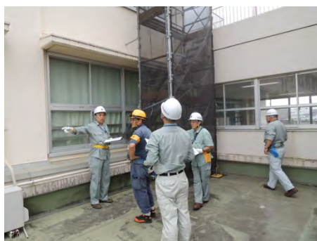
足場設置状況などの確認
