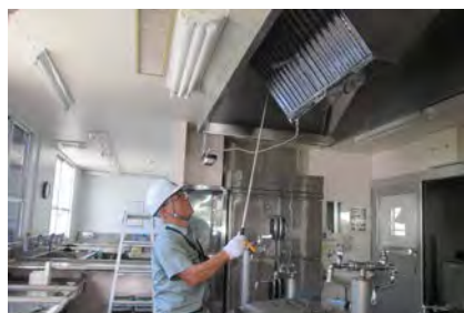
市立学校点検状況
