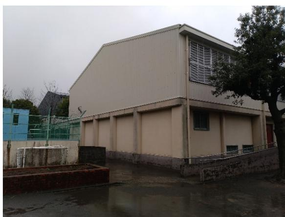
霧が丘学園小学部の屋内運動場の外壁が令和元年9月の台風被害で破損してしまったため、鉄骨下地を補修のうえ、耐候性に優れたガルバリウム鋼板で外壁改修工事を行いました。
