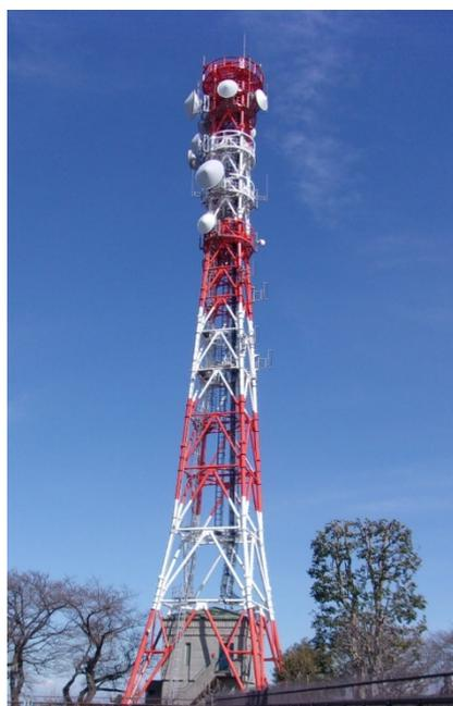
西谷無線中継所鉄塔の塗装と航空障害灯の改修工事を行いました。鉄塔の高さは地上より65mあり、高層の足場組となるため、慎重に工事を進めました。地面から約10mまでは枠組足場で、その上は吊り足場としました。地上では微風であっても、上部では強風となるため、風速10mを超える場合の作業は中止とし、作業中における墜落防止、塗料や塗膜等の飛散防止には特に注意を払い作業を行いました。
