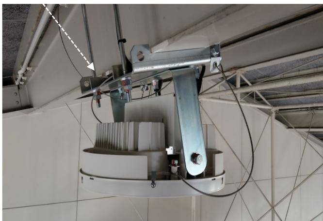
学校の体育館に設置されている高天井用照明器具やステージ及び器具庫等付帯施設の照明器具を水銀灯からLED型照明に更新する工事です。
