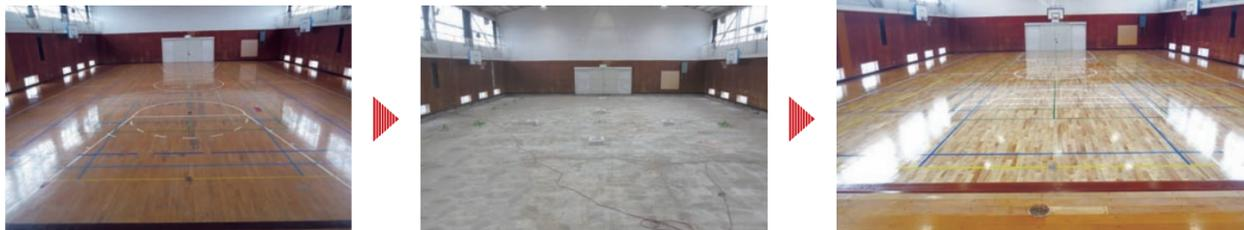
傷みが出てきた木製の床を、平滑に研磨、再塗装しました。
