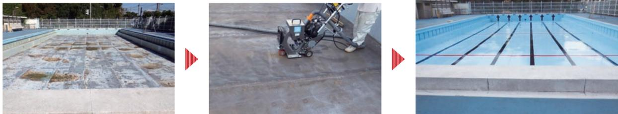
塗装がはがれ始めていた鉄板製プールを、研磨、補強し、再塗装しました。
