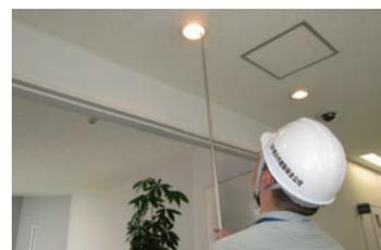
非常用照明の点灯を確認します。一灯ずつすべての点灯を確認します。
