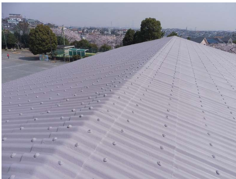
■目視調査 屋根(棟周辺部)
