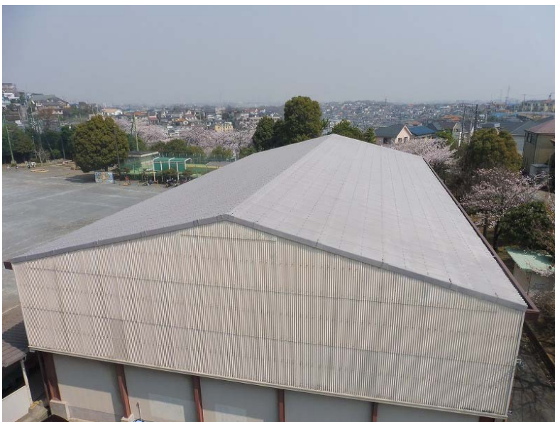
■目視調査 全景(西側妻面)
