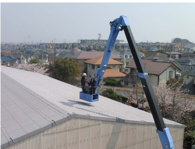
■目視調査 調査状況
