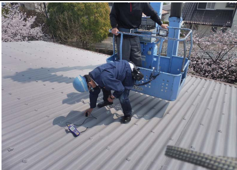
■膜厚測定 測定状況 南側
