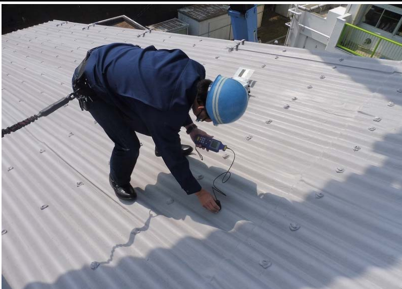
■膜厚測定 測定状況 西側
