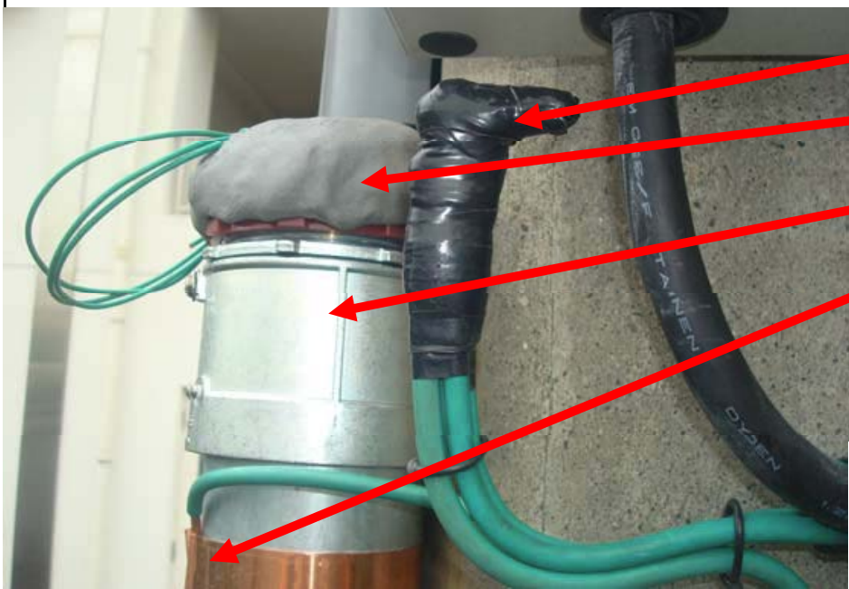
A種接地 接地試験用端子 黒色自己粘着テープ巻
