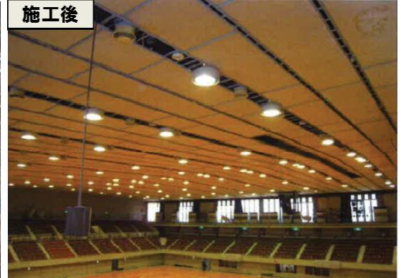
体育馆に設置されている照明器具、操作盤等を更新する工事です。高所に設置されている器具を更新するため、移動式足場（ローリングタワー）や仮設足場を使用する必要があります。平成25年度に行った横浜文化体育館の照明改修工事では、ほぼ全面に仮設足場を設置しました。
