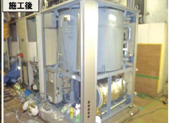
空調設備の熱源である「冷温水発生機」を修繕する工事です。限られたスペースの中で大型部品の撤去、搬入も伴うため、施設運営や周辺設備への影響を与えないよう、養生も含めた慎重な施工が求められます。左側写真は既設の発生機を撤去した時のもの、右側は新設の発生機を設置したところです。
