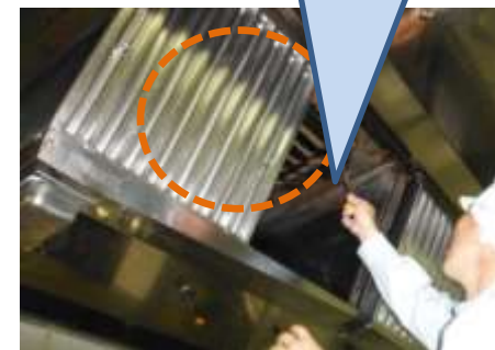
防火シャッター 厨房排気フード のグリスフィル ターの中
