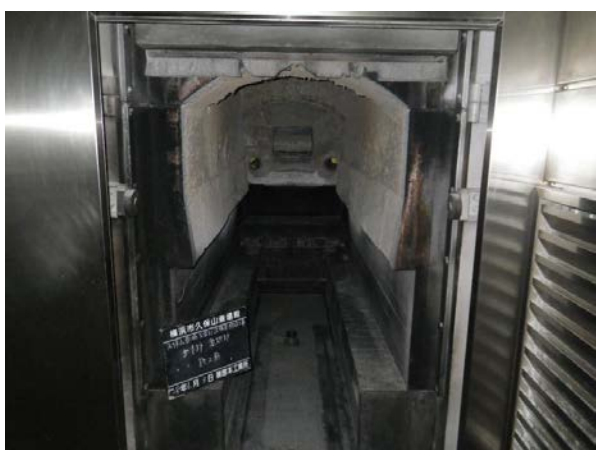
施工前（燃焼炉）
