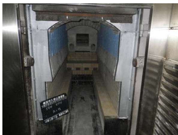
施工後（燃焼炉）
