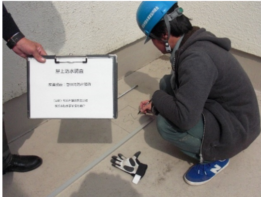
ウレタン防水の劣化サンプル採取 (菅田消防出張所)
